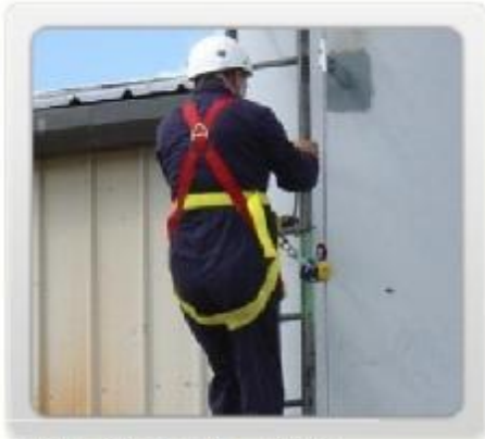
شکل ۷۶- صعود از نردبان با ابزار متوقف‌کننده
