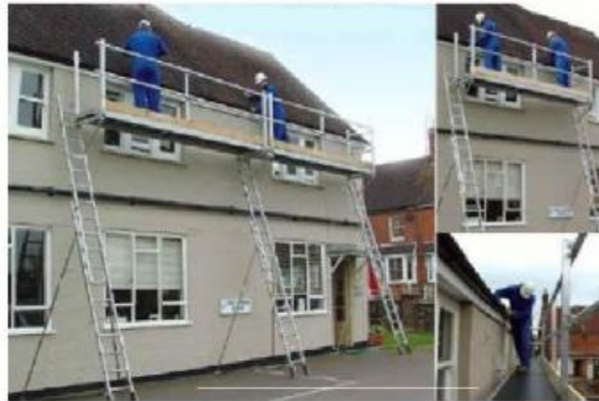
شکل ۳۲- جایگاه کار با استفاده از نردبان
