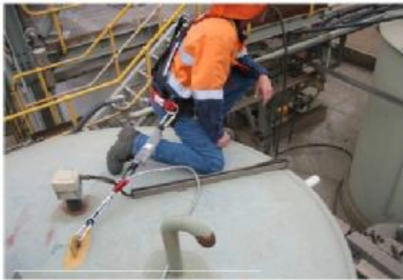
شکل ۳-۵۴ محدودکننده با اتصال یک نقطه
