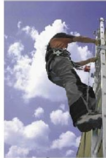
شکل ۷۷- صعود از نردبان با ابزار متوقف‌کننده
